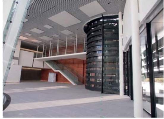
日清食品八王子研究所 内部天井ルーバー
