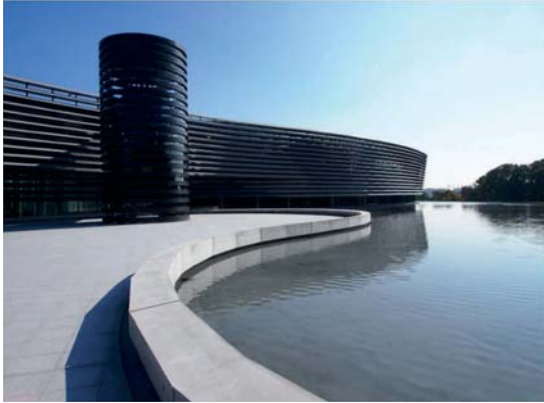
日清食品八王子研究所 外部ルーバー
