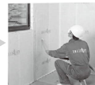
デコスドライ工法 壁へのブローイング施工状況
